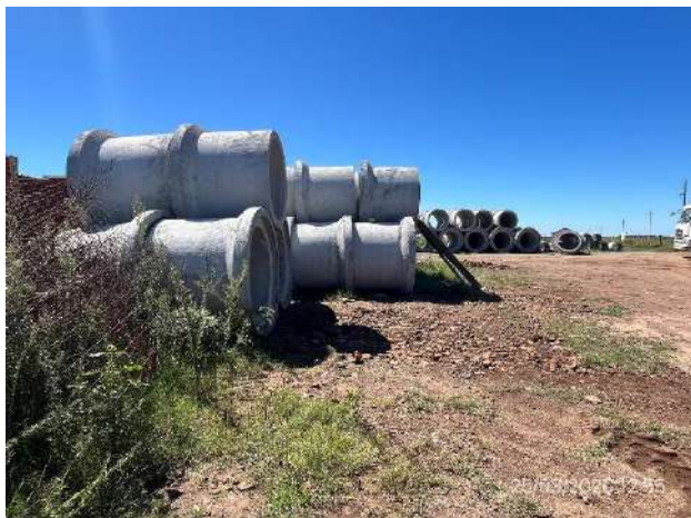
Foto 12.1-9, P03. Obrador, explanada de acopio de tuberías de hormigón fabricadas in situ. Buenas condiciones de orden y limpieza
