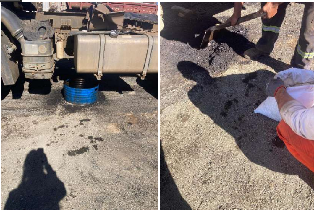
Foto N°3 y 4: Derrames alrededor de la bandeja. Recolección del derrame luego de capacitación.
